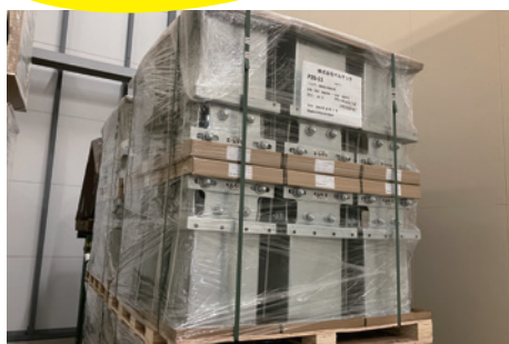
工場生産品を設置
