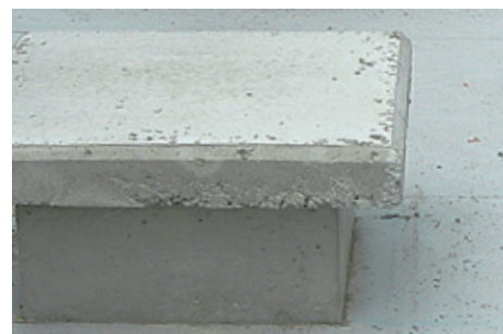
手直しが発生しやすい。更に頭部へアンカーボルト穴の穿孔が必要
