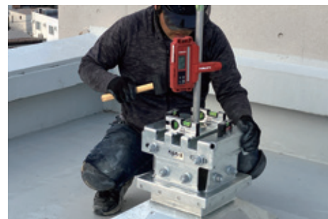
③mm単位で高さ・水平調整が可能
