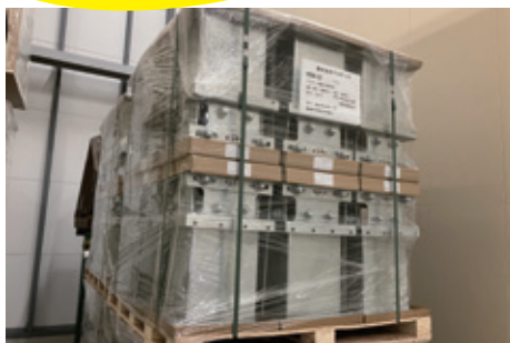
工場生産品を設置
