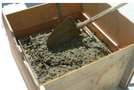
小規模工事の小型構造物では機械を用いた締め固めが面倒
