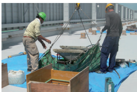
小規模工事ではコンクリートの揚重が大変(既存建物での施工例)
