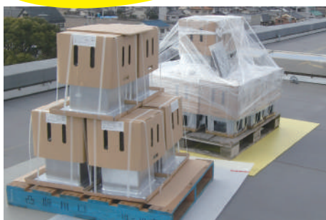
工場生産品を設置
