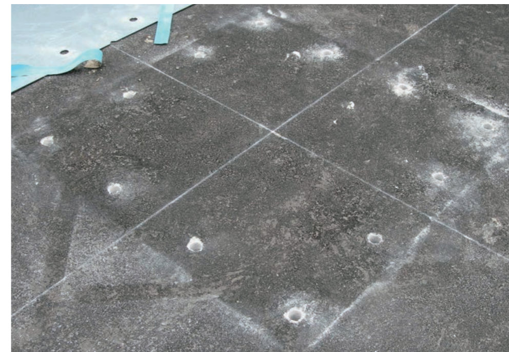
1基につき12箇所穿孔する。
