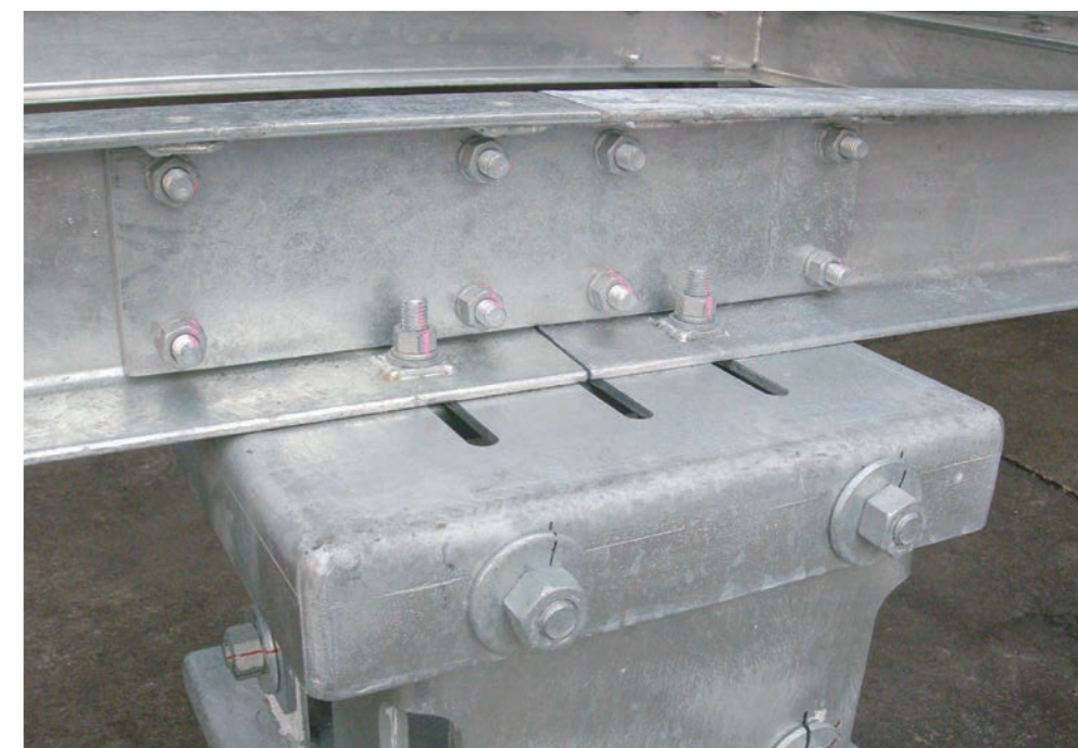
ベルベースA/外アンカーの上部に設備架台を取付け、設備を設置。(H鋼を頭部へ取付けるボルトは別途)
