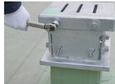
⑥高力ボルトを、所定のトルク及び回転角に従って締付ける。
