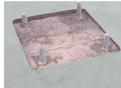
③アンカーボルトを設置
