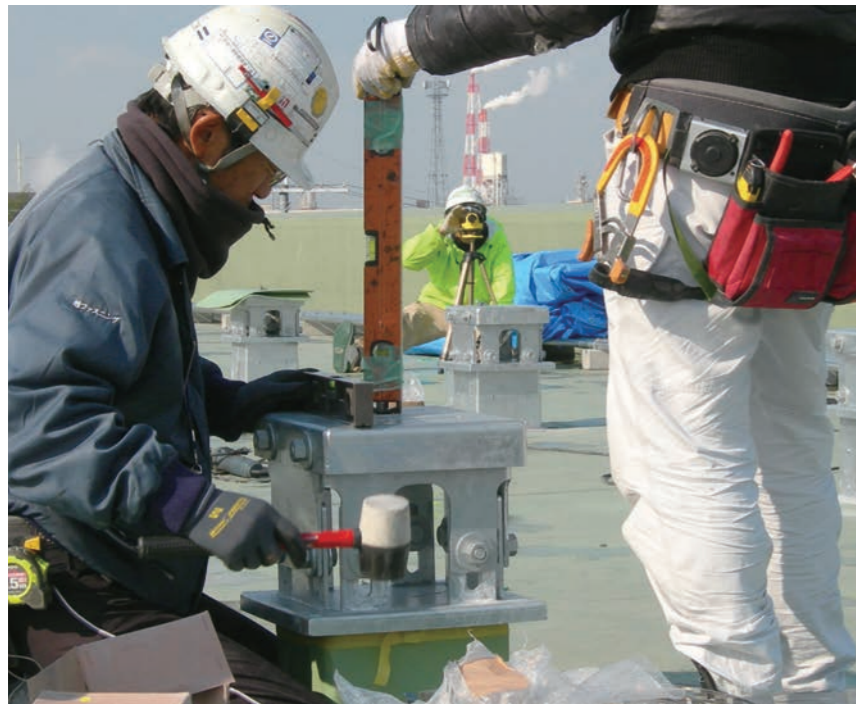
⑤頭部高さ及び勾配を調整。(調整ボルトを仮締めし、レベル等に合わせて四隅を樹脂ハンマーで軽く叩く)
