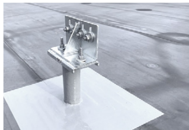
塩ビシート防水へ基礎を固定し、基礎周囲はウレタン塗膜防水を施工
