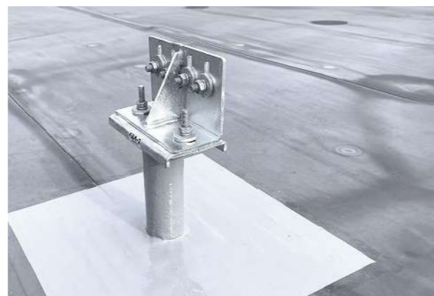
塩ビシート防水へ基礎を固定し、基礎周囲はウレタン塗膜防水を施工
