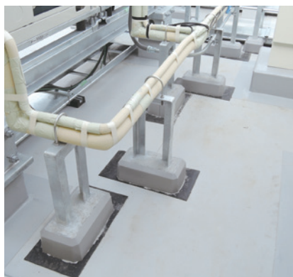
固定されていない重い置き基礎は、地震時に揺れると、かえって配管類の被害を拡大させる
