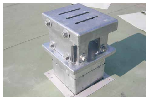
③mm単位で高さ・水平調整後、完了
