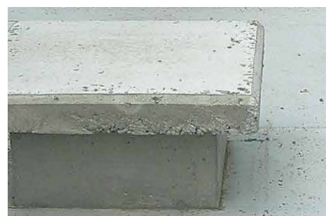
手直しが発生しやすい。更に頭部へアンカーボルト穴の穿孔が必要
