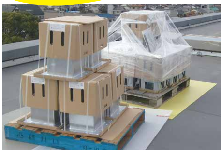
工場生産品を設置
