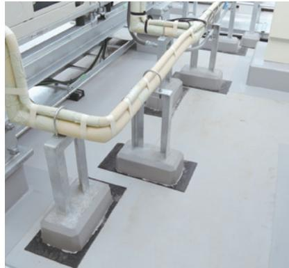
固定されていない重い置き基礎は、地震時に揺れると、かえって配管類の被害を拡大させる
