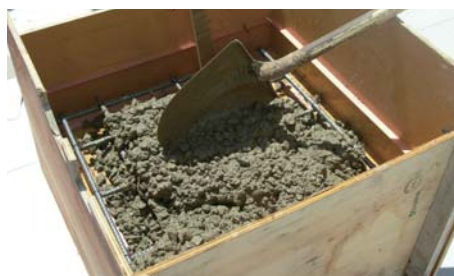
小規模工事の小型構造物では機械を用いた締め固めが面倒
