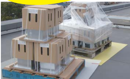
工場生産品を設置
