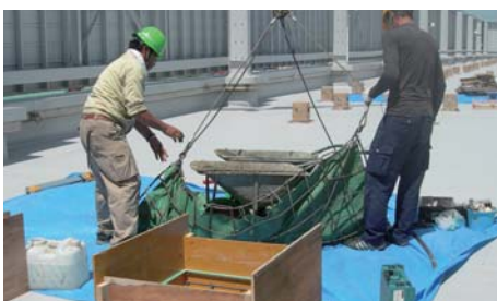
小規模工事ではコンクリートの揚重が大変
