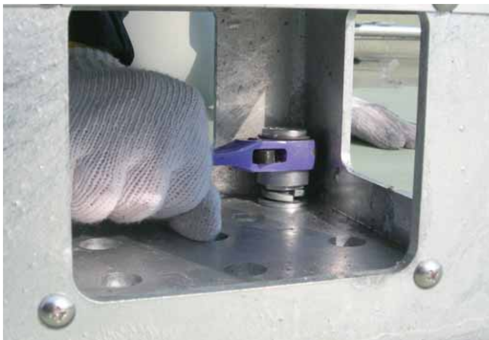
ベルベース本体の操作窓から手を入れ、アンカーボルトのナットを締める。
