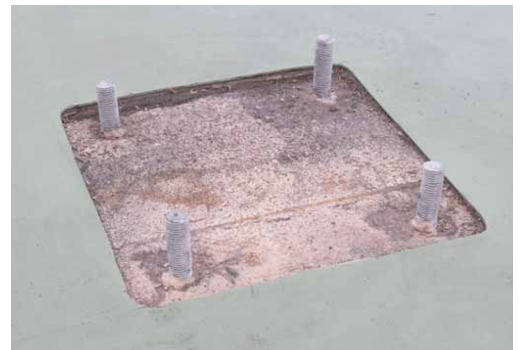
既存防水層を撤去し、保護コンクリート又はスラブを露出させ、アンカーボルトを取付ける。
