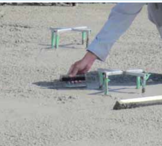
アンカーボルト打込フレーム
